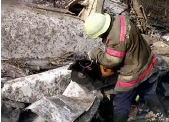
Rys. 3. Cięcie wraku piłą mechaniczną [13].
